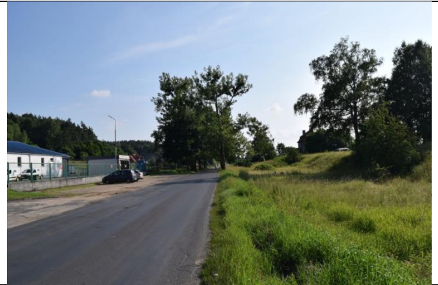
Fot. Widok na drogę powiatową nr 1209P Walkowice – Czarnków. (07.2017r.)
